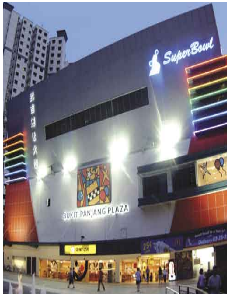
Bukit Panjang Plaza
