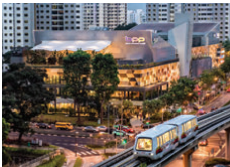
4. Bukit Panjang Plaza
